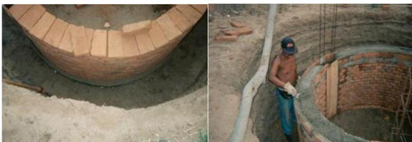
Figura 4. Alvenaria sem rejuntamento. Cinta de amarração.
