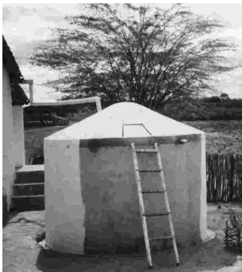
Figura 3. Acabamento e pintura. Fonte: Schistek (2014).
