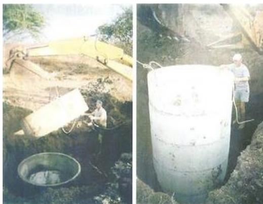
Figura 2. Instalação dos anéis sobrepostos.
