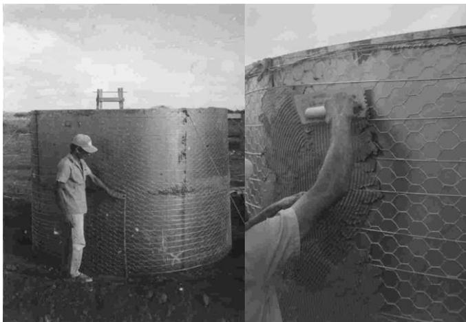
Figura 2. Montagem da tela e acabamento. Fonte: Schistek (2014).
