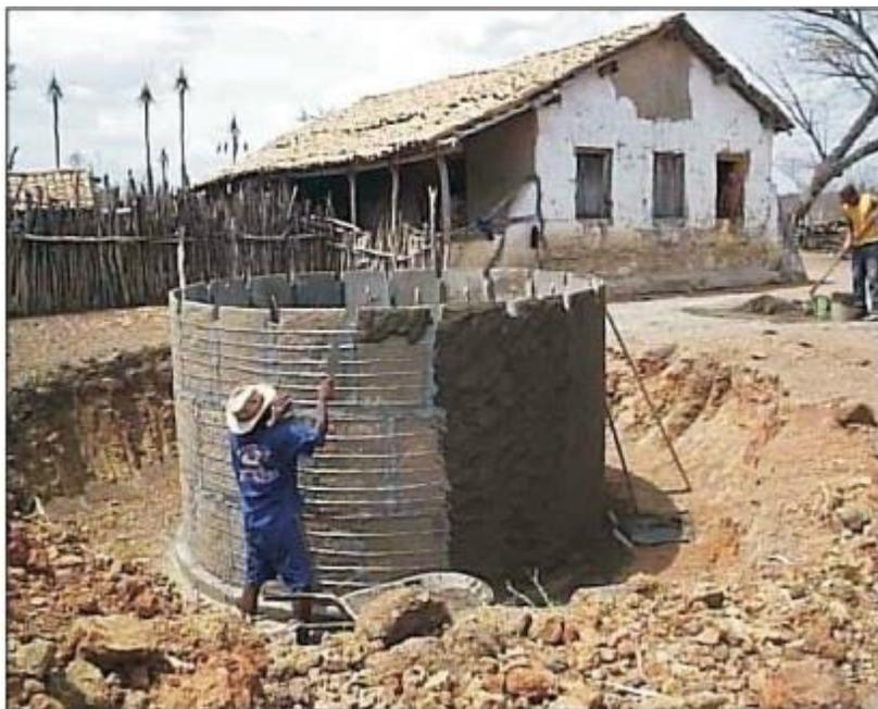
Figura 8. Aspectos do reboco externo da cisterna.
