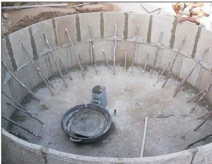
Figura 5. Detalhes da montagem da segunda fileira de placas.
