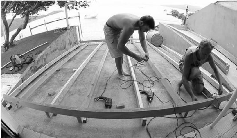
Figura 2. Construção da estrutura de madeira da plataforma.
