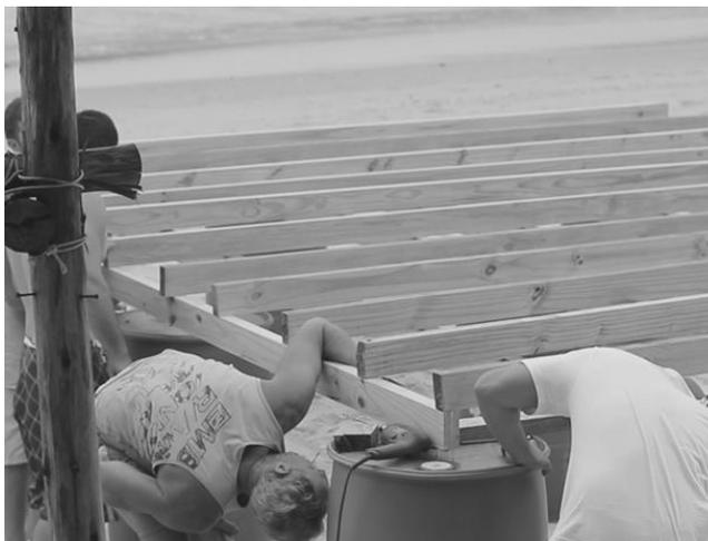
Figura 4. Posicionamento dos barris na estrutura. Fonte: Mallon (2012).
