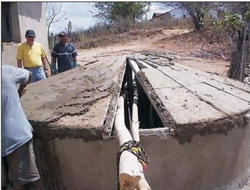
Figura 7. Detalhes da montagem da tampa da cisterna.
