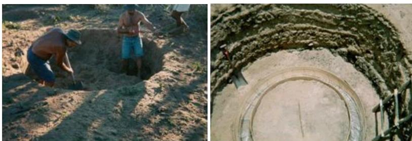
Figura 2. Escavação e início da moldagem da sapata cortante.
