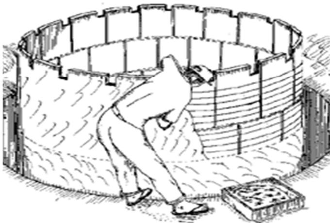
Figura 1. Construção da cisterna (Montagem e revestimento).
