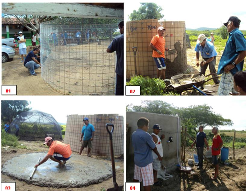
Figuras 1 a 4. Construção da cisterna alternativa da UDPAF do PA
